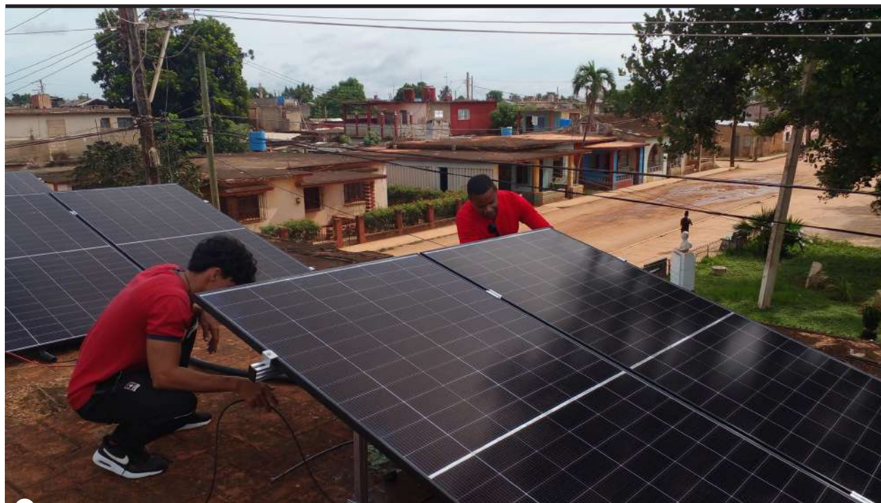
INGENIEROS Y TÉCNICOS DE LA MIPYME Espoleta Tecnologías laboraron en la instalación del sistema fotovoltaico que garantiza la vitalidad energética del policlínico
