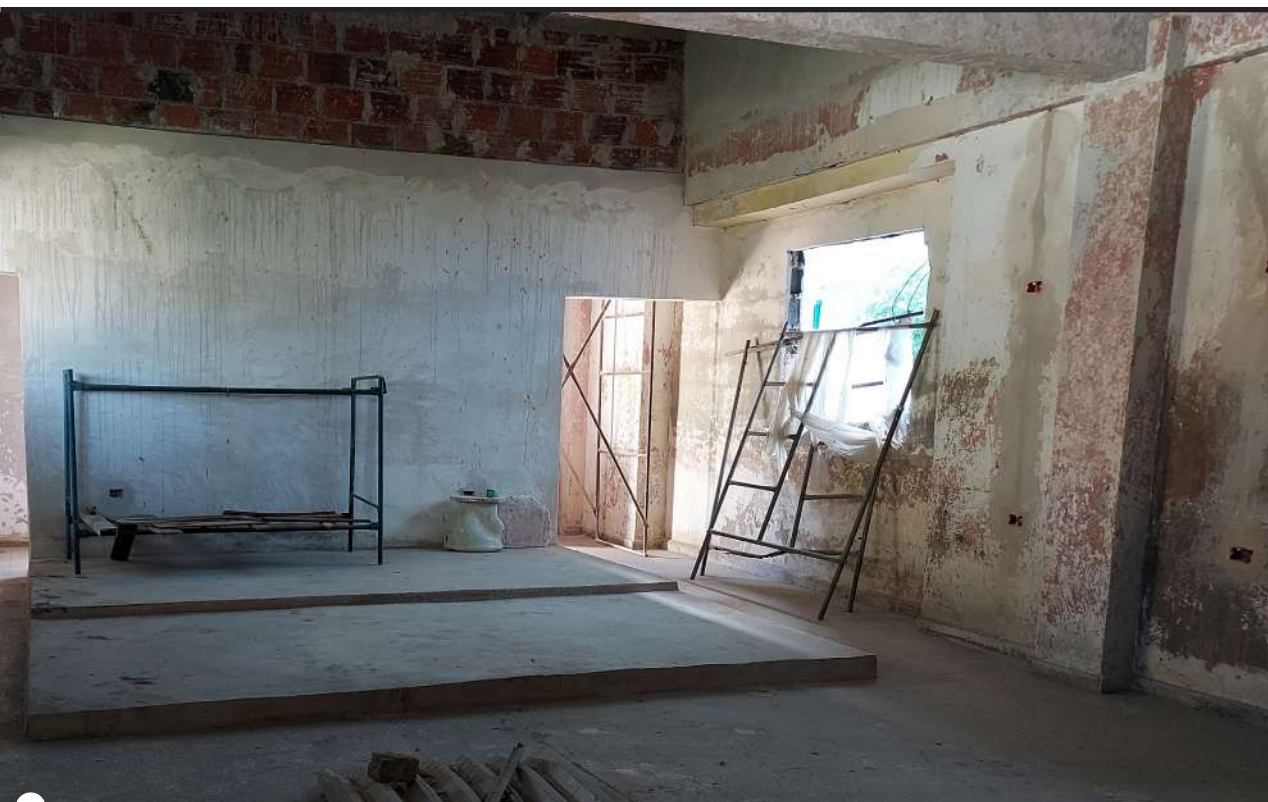
INTERIOR de la obra en pausa
