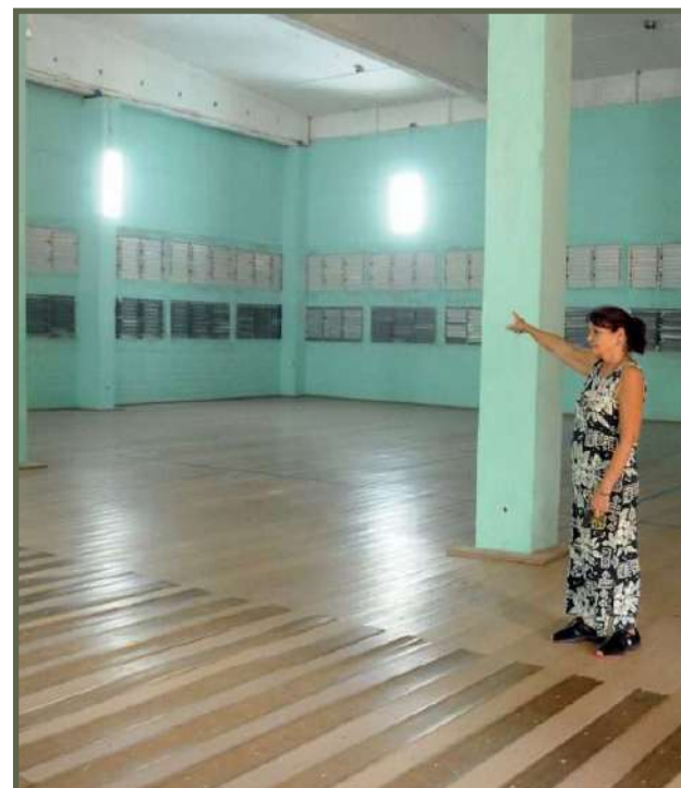
DALILA en el gimnasio de la escuela, recientemente reparado
