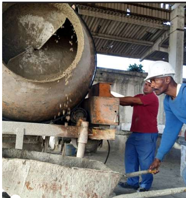
LA MEZCLA para las losas debe quedar como una pulpa
