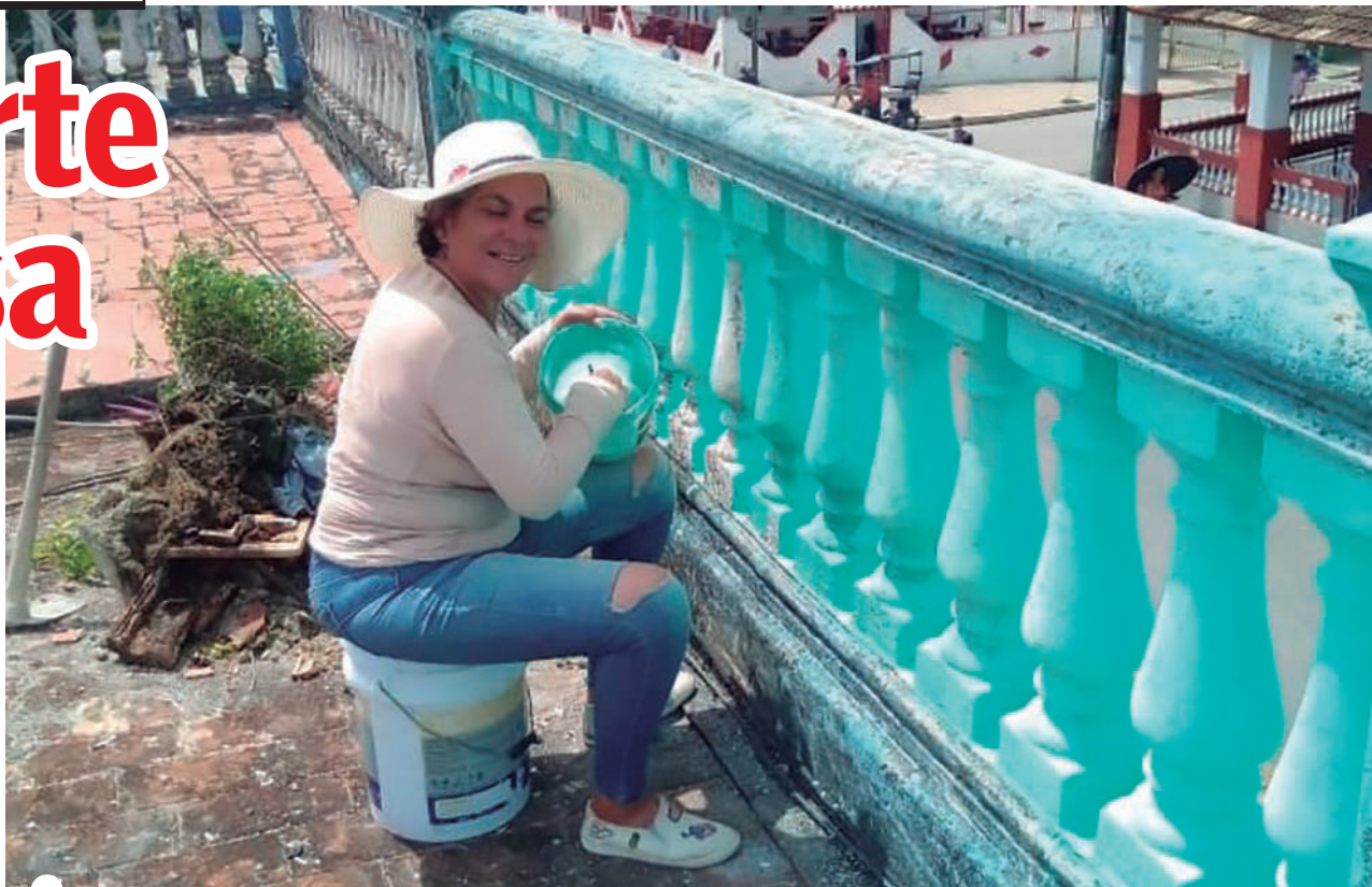
MILAY en plena faena constructiva
