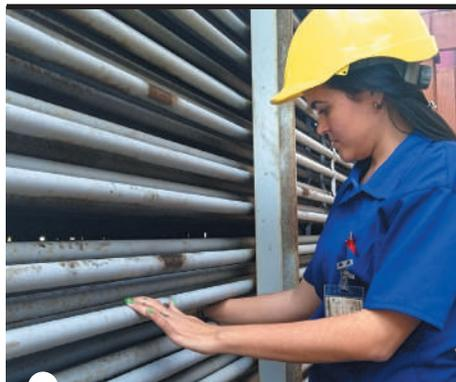
**DAYLÍN** comprueba la efectividad del lavado del paquete de tubos del economizador que serán instalados como parte del mantenimiento del bloque 8
