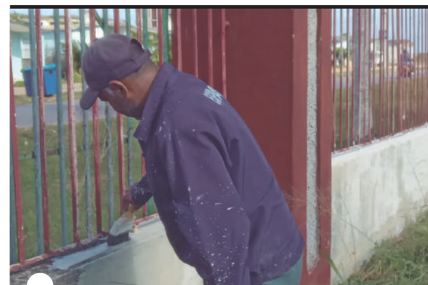
LA REPARACIÓN y pintura de la cerca perimetral la ejecutó una brigada de la Empresa de Construcción y Mantenimiento
