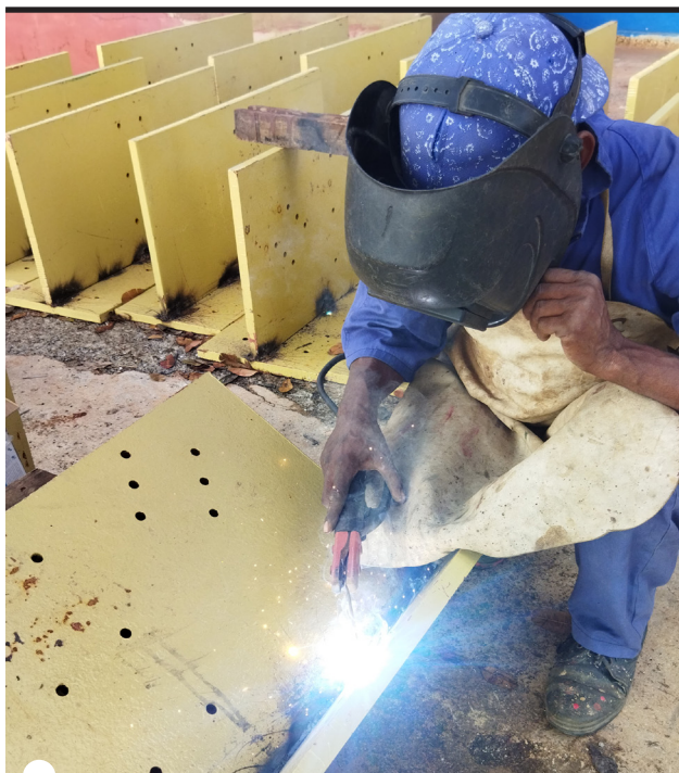
DOS BRIGADAS de siete hombres trabajan 24 horas; los soldadores prácticamente no descansan
